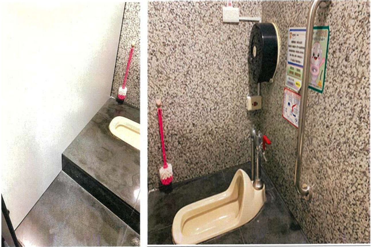
說明：廁所隔間採反偷拍設計，蹲式廁間加設安全扶手，並降低緊急鈴高度，顧及隱私及安全。
