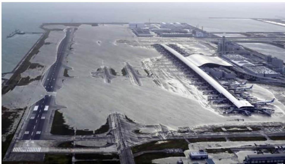
關西國際機場淹水情形
