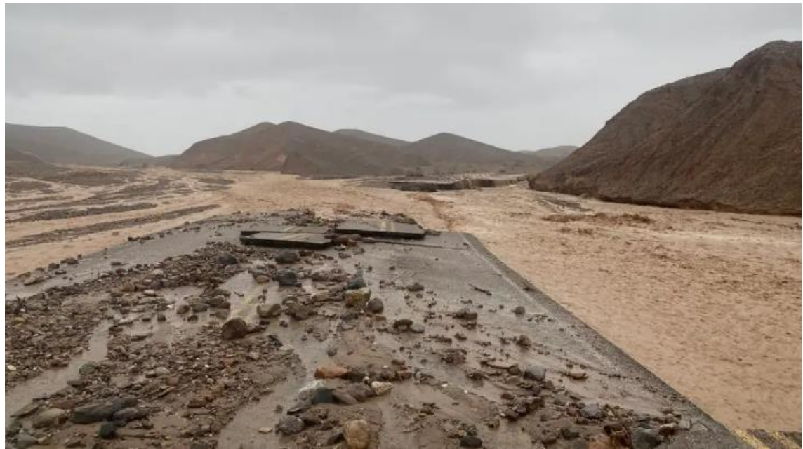
◆ 8月5日死亡谷國家公園道路受災情形
